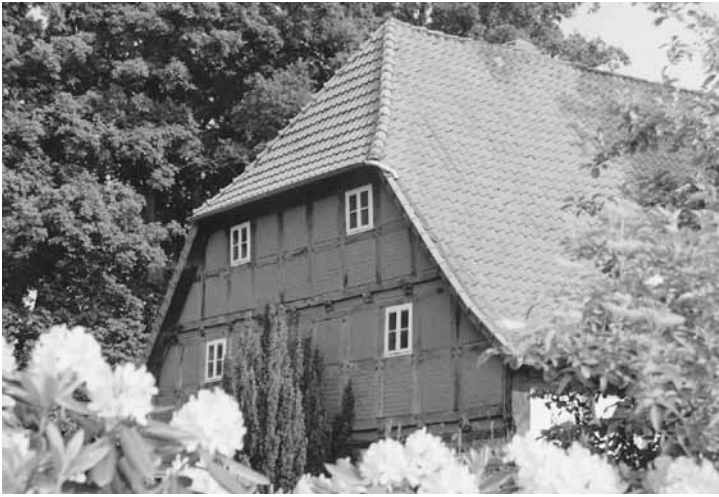
Das Stammhaus der Auburg Quelle wurde im Jahre 1786 von Wilhelm Lütvogt auf der alten Hofstelle im Amt Auburg erbaut. Noch heute ist es das Herz des modernen Mineralbrunnenbetriebes.
