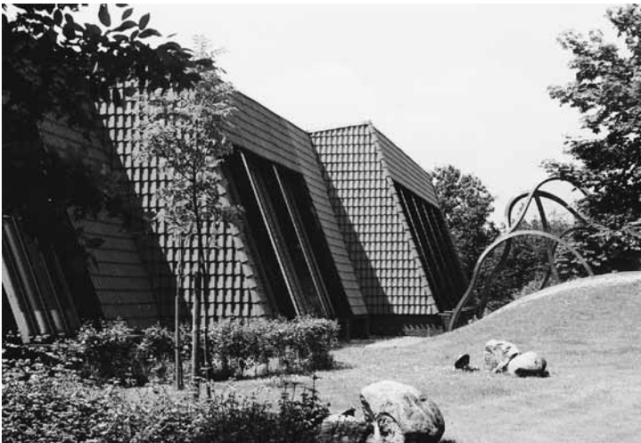
Der Mineralbrunnenbetrieb der Auburg Quelle ist mit traditionellen Baumaterialien vorbildlich in die natürliche Landschaft am Naturpark Dümmer eingefügt.
